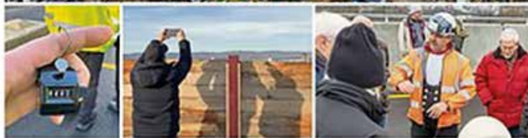
Tausende statten der neuen Salzachtalbrücke einen Besuch ab. Schon gegen 14 Uhr zeigt der Zähler fast 8500 Personen, Fotografen recken sich über die Holzwand auf der Nordseite, und der Bauleiter Manfred Lengert beantwortet Fragen. Foto: Lukas Görlich/André Domes
