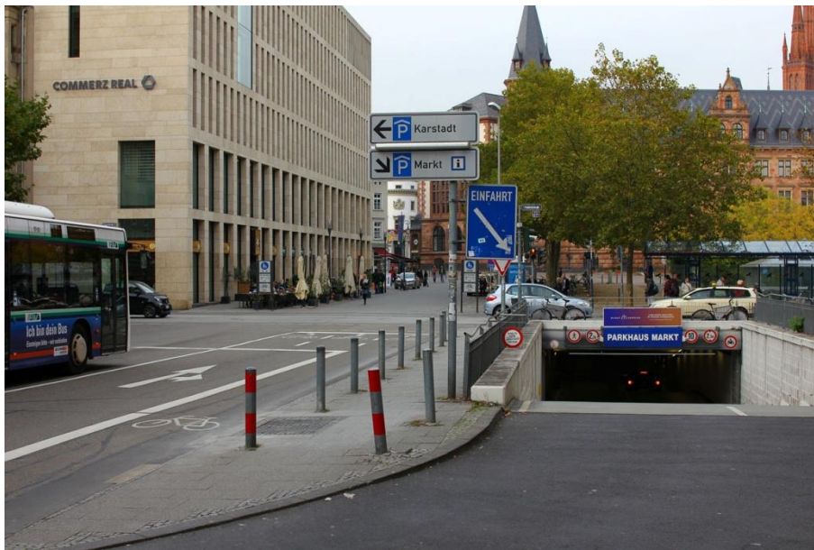
Abbildung 2-50: Zufahrt Tiefgarage Markt
