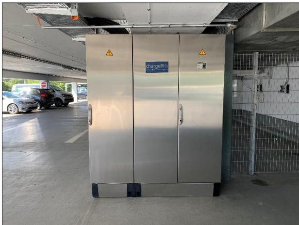
Abbildung 20: Zentralisierte Ladesysteme, Firma Mahle System „ChargeBig“
