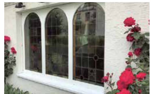
Einbau einer alten Bleiverglasung in moderne Fenster mit Dreifachverglasung
