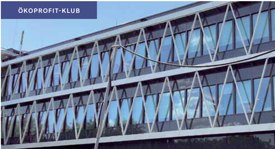
Die neue Fassade am Hauptsitz
