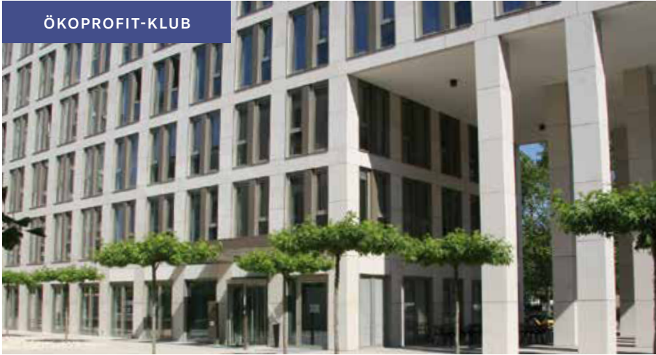
SOKA-DACH im Büroquartier VERSO in Wiesbaden
