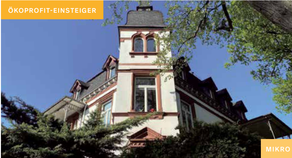
Agenturräume mit Ausblick am ÖKOPROFIT-zertifizierten Standort Alwinenstraße
