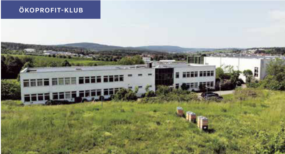
PV-Anlage auf allen Dachflächen der WERO-Gebäude und Bienenvölker
