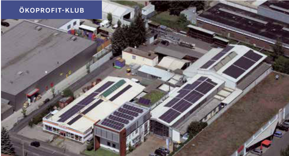
Gelände der Firma Huhle mit Photovoltaikanlagen
