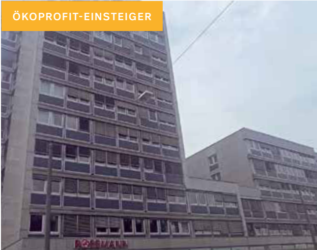
Blick auf gesamtes Gebäude
