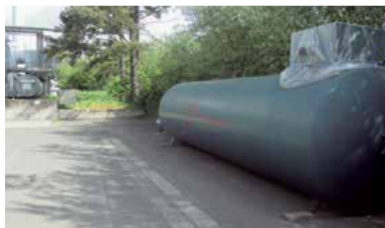
Zusätzlicher Lösemittel tank für Ethylacetat
