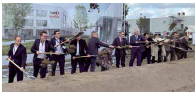
Spatenstich für das neue Verwaltungsgebäude in Mainz-Kastel, vorgesehen DGNB-Zertifizierung Gold
