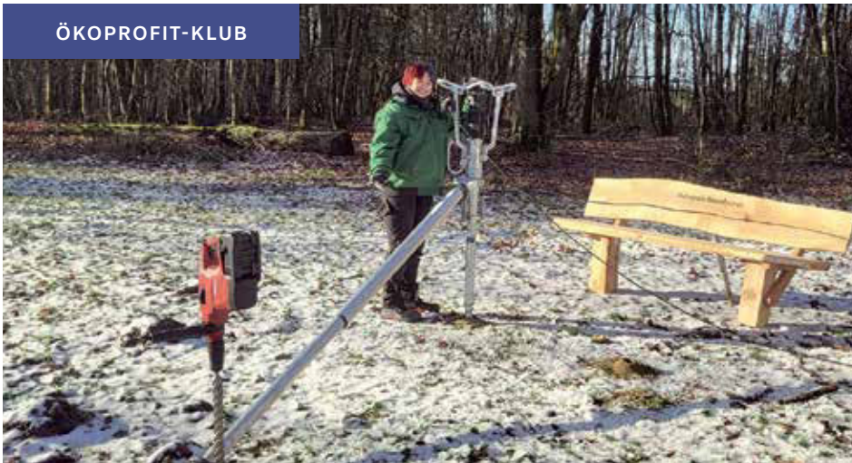
Neues Fundamentsystem im Einsatz
