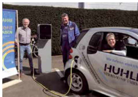
Unser Umweltteam an der Ladesäule für E-Fahrzeuge
