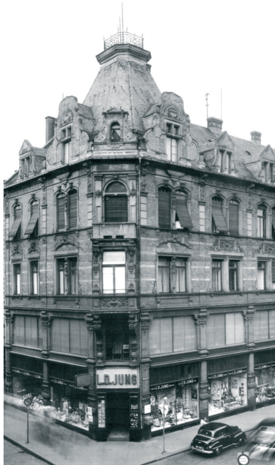
Hist. Aufnahme des Lorey-Gebäudes (um 1960) 105
