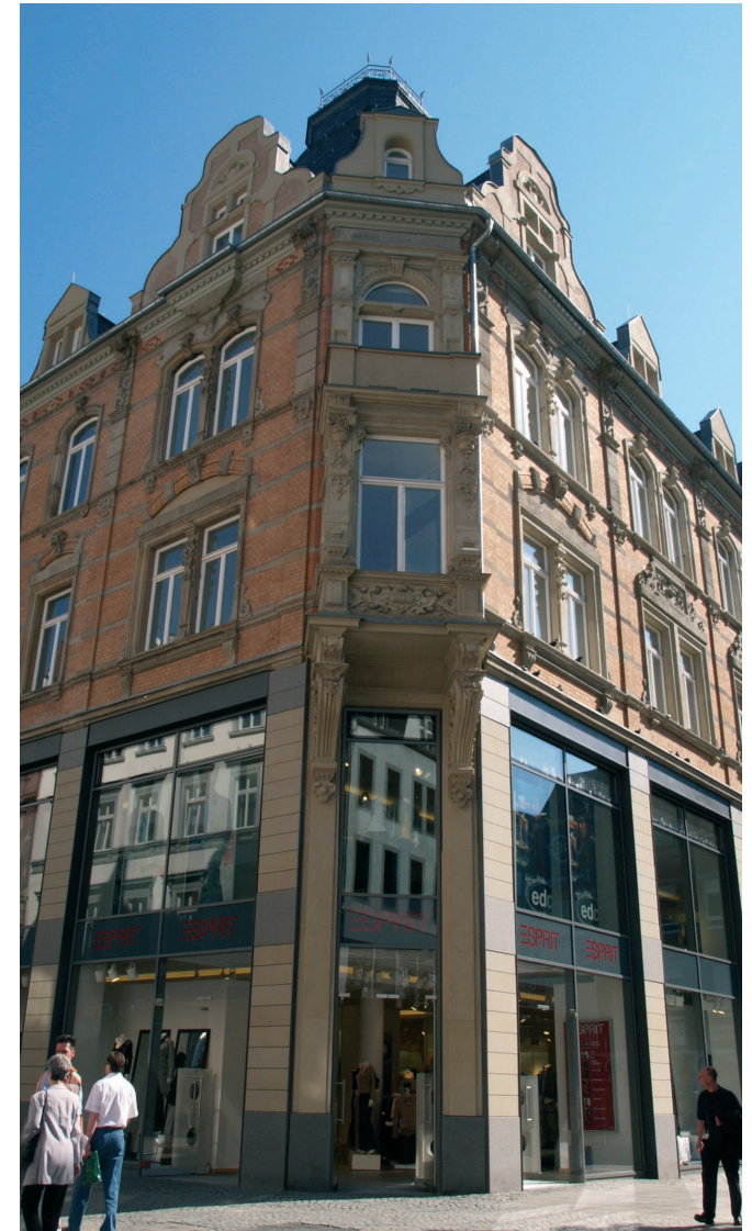
Gebäude nach Sanierung der Ladengeschosse (Mitte 2004) 107
