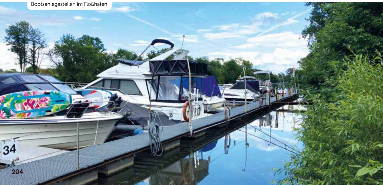
Bootsanlegestellen im Floßhafen
