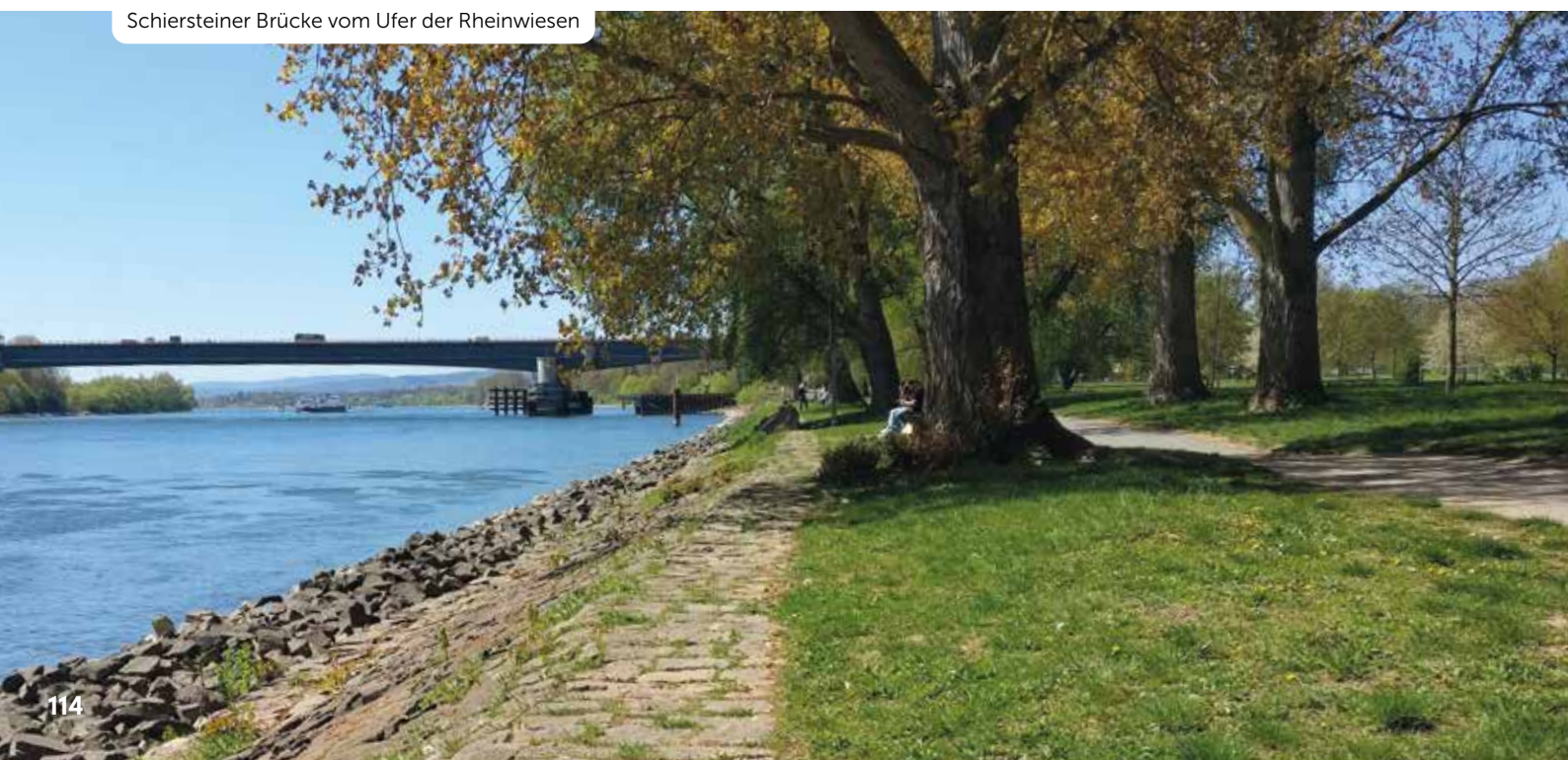
Schiersteiner Brücke vom Ufer der Rheinwiesen
