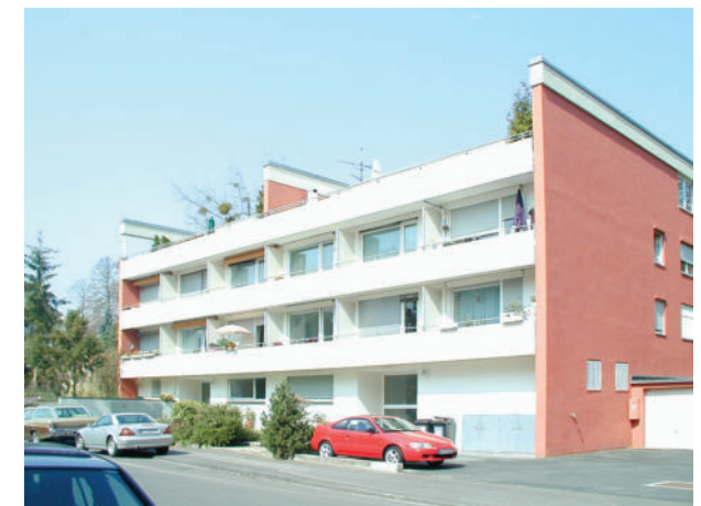
Störendes Gestaltungselement: durchgehende Balkonbänder
