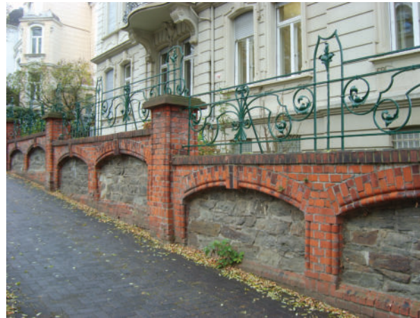
Stützmauer aus Ziegel und Naturstein
