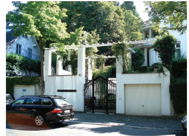
In die Gestaltung der Einfriedung integrierte Garage
