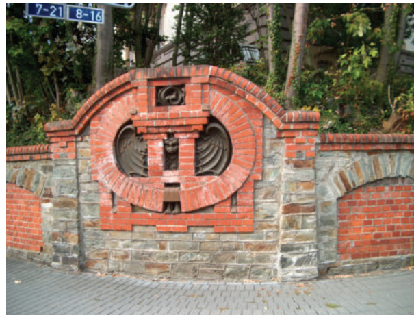
Stützmauer mit betonter Eckausbildung
