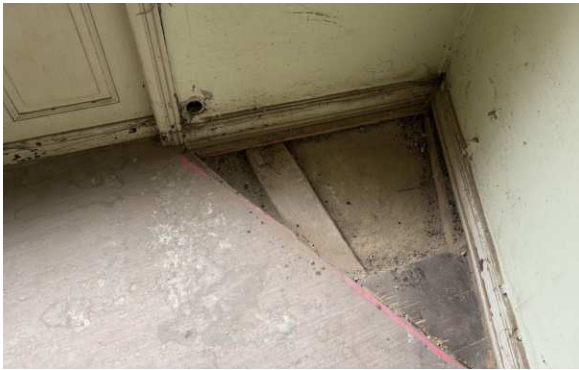
Decke 2. Obergeschoss: Erkundung Deckenaufleger
