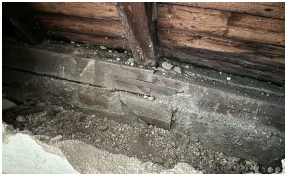
Decke 3. Obergeschoss: Erkundung Deckenaufleger
